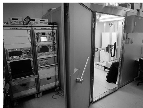
計測器とシールドルーム
